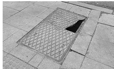
昨日,记者在北文萃路与青年大街交叉路口北侧看到,人行道内有一个铁制方形井盖出现破裂,其中一块三角形的井盖盖板已经掉落,存在较大的安全隐患,请相关部门及时维修。
