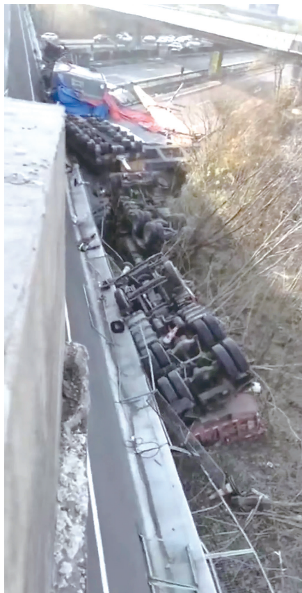
事发现场,桥梁下方有车辆被压。
