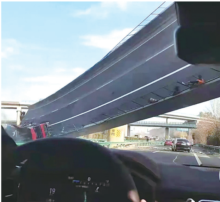
事发现场,跨空匝道桥梁侧翻。
