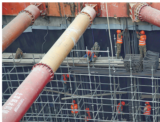
地铁一号线东延线 世博园站将年底封顶 06
