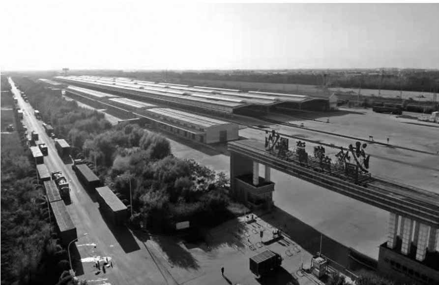
沙岭综合物流园
