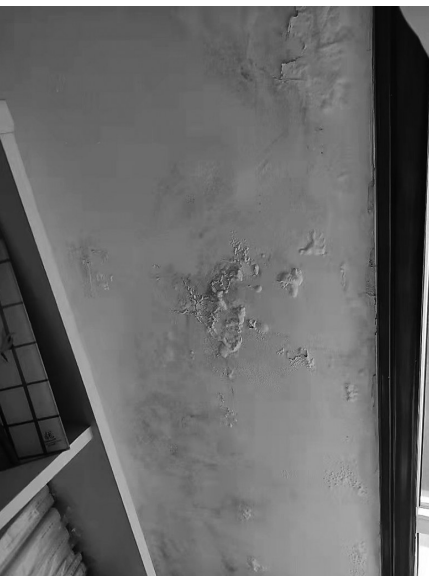
墙体漏水后起鼓长毛。
