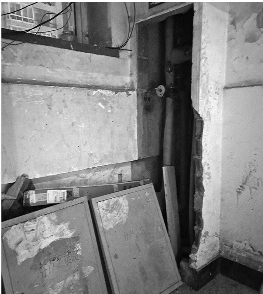
记者来到该楼,看到新更换的主管道进入楼体后仍然接入原管道井内,施工过程中对管道井进行了不同程度的拆除。垒砌管道井的红砖被拆得参差不齐,暖气管外露,拆下来的管道井门体都堆在楼道内,给居民上下楼带来许多不便。
