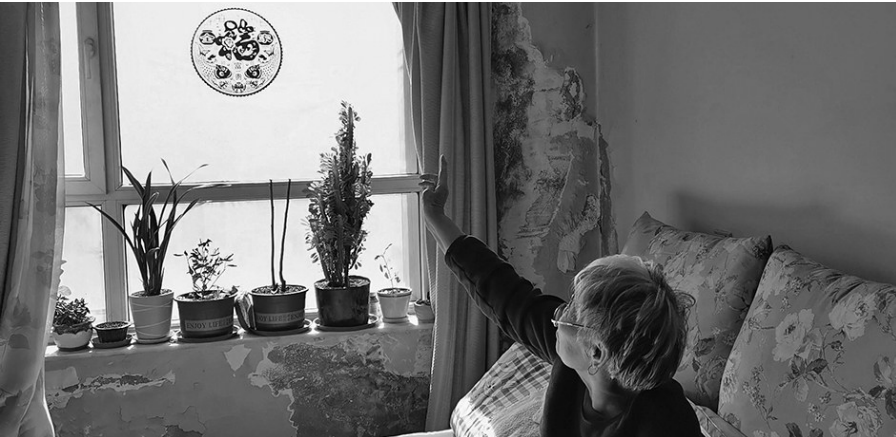
屋顶漏雨造成墙壁霉变生黑斑。
