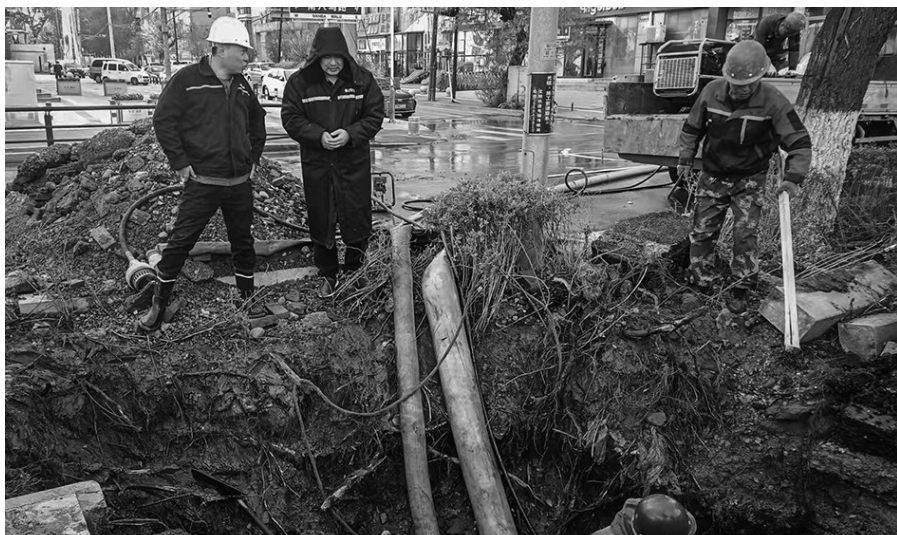
关平(左一)与工作人员在自来水管线泄漏现场研究抢修方案。 辽沈晚报记者 吴章杰 摄
