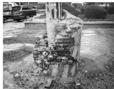
在沈阳市南阳湖街与仙女河北路交叉口东南角,有一根水泥电线杆底部的防撞保护台损坏严重,不少碎裂的砖头散落在地,不仅存在安全隐患,还影响市容,希望相关部门及时处理。
