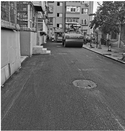
施工人员正在对园区内的破损路面进行重铺。
