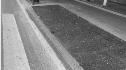
8月27日,“辽沈帮帮帮”吐槽了十三纬路19号附近的人行横道正对着半尺高的马路边石,自行车和电动轮椅从此经过时比较吃力。昨日,读者通过QQ告诉记者,相关部门已经将边石降低,与机动车路面平齐,又将非机动车道做了一个缓坡,走在重新压过的路面上感觉非常贴心。 辽沈晚报记者 金国建 读者供图
