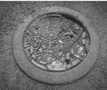
在沈阳市沈辽路与金龙湖街交叉口南侧的路西,机动车道中间一井盖碎裂,井盖内部和四周有许多金属片,对途经此地车辆的轮胎构成威胁,希望相关部门及时修缮。 辽沈晚报记者 吴章杰文并摄
