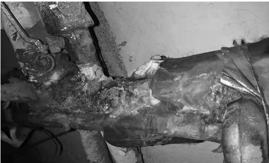
楼道内供暖管线锈蚀严重。 辽沈晚报记者 崔晋涛 摄
