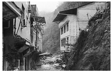
四川达州大竹镇发生山体滑坡。
