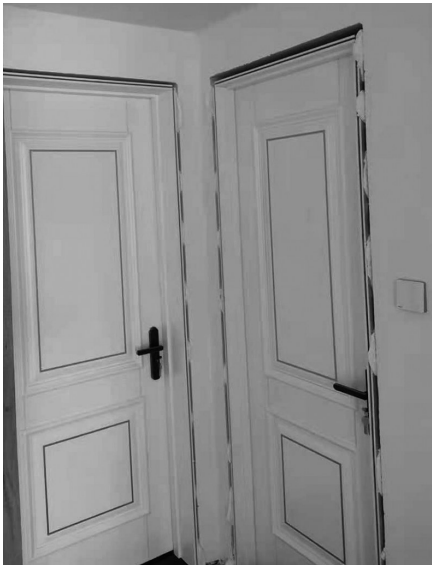
房门框口条没安完。
