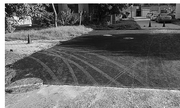
小区填补路面,浇筑沥青。
