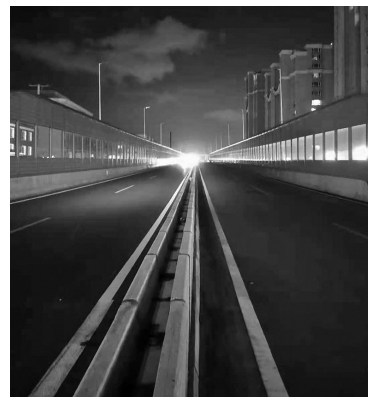
昆山西路高架桥路灯不亮。 读者供图
