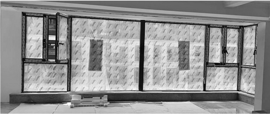
中间两块大玻璃存在晃动,周女士认为与装修公司用5毫米玻璃替换6毫米玻璃有很大关系。 读者供图
