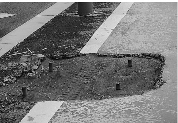
4根金属螺栓突出地面六七厘米。
