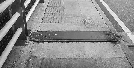
金属板已经切割，处理平整。
