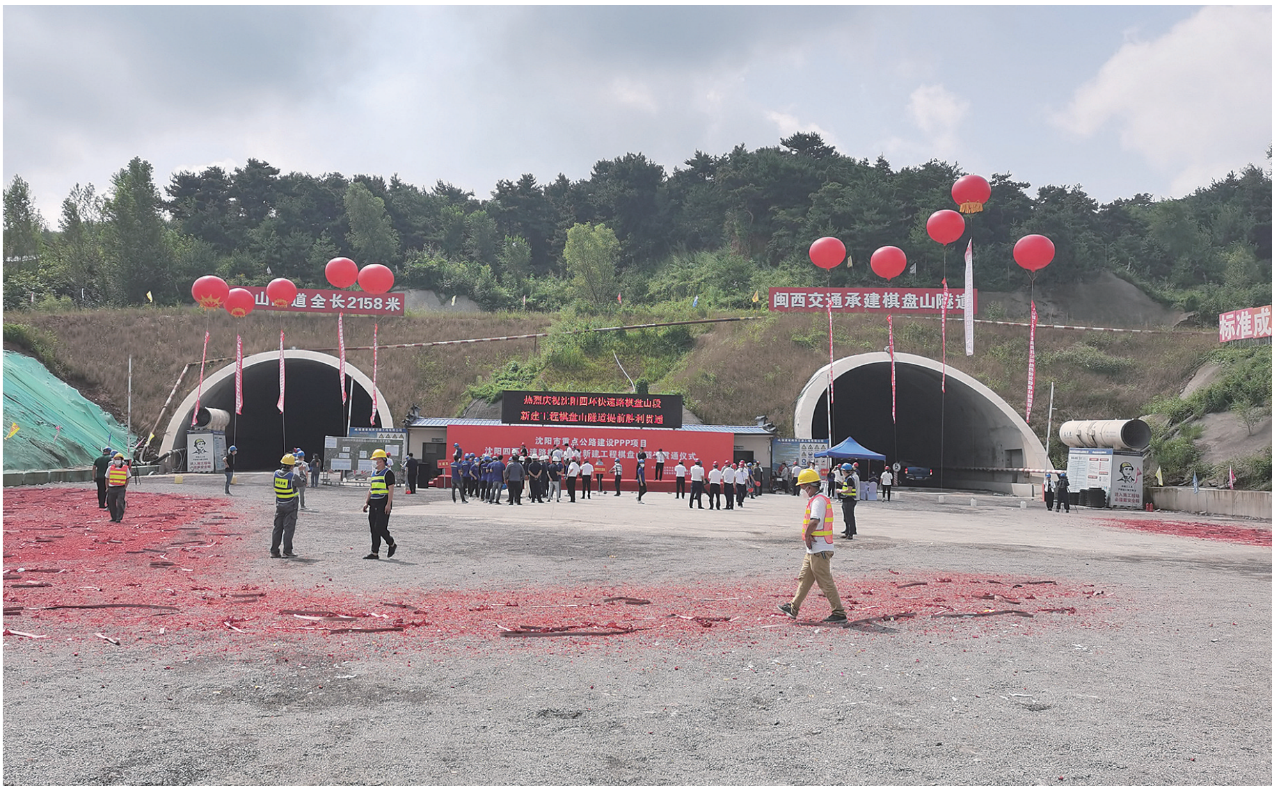
隧道洞口采取双洞形式单洞各三车道。
