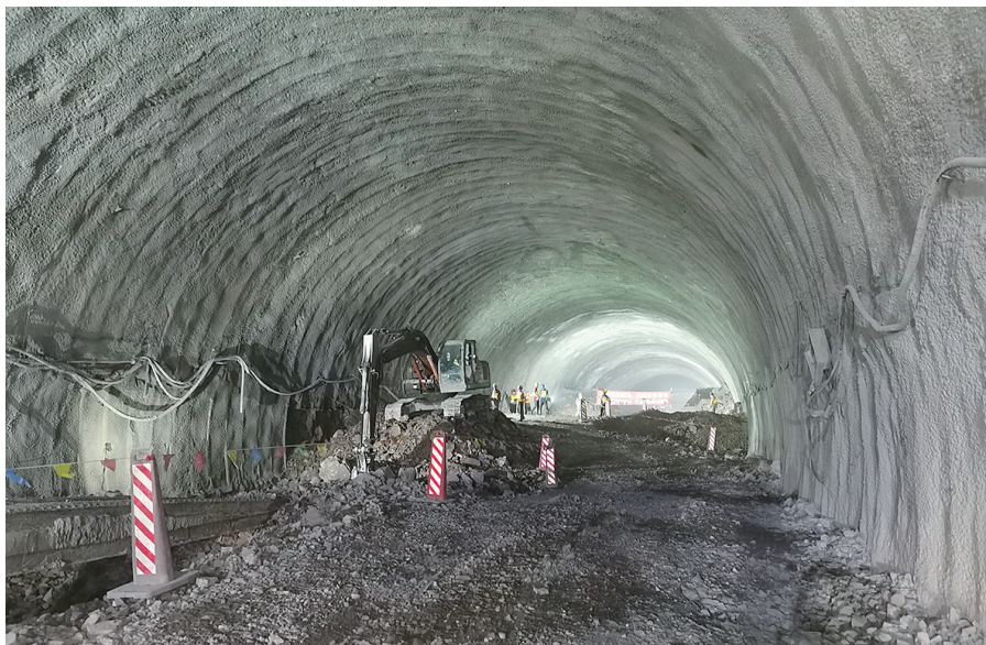
爆破点位于隧道中部,施工正在进行仰拱施工。
