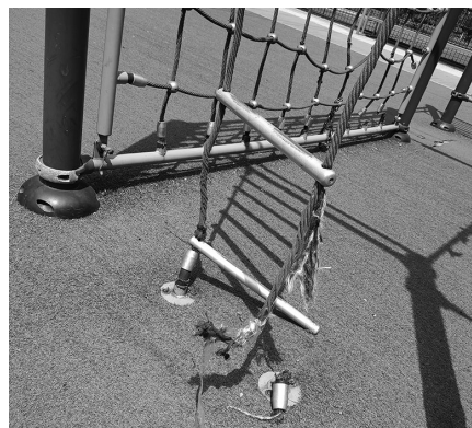
绳梯和侧面的绳索损坏严重。
