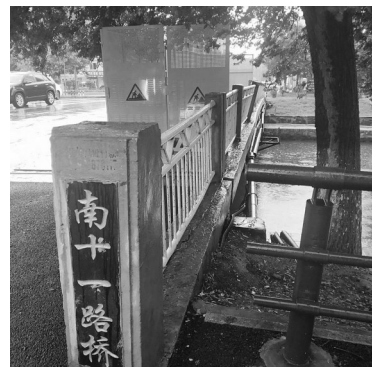
护栏倾斜处立起了施工围挡。
