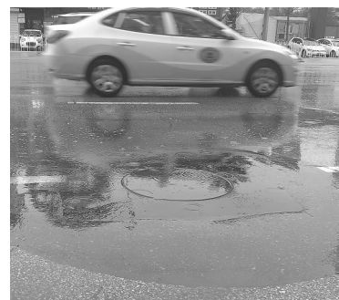
井盖旁路面已经铺满沥青。
