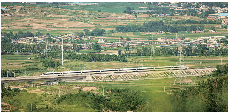
辽宁朝阳至凌海南高速铁路将于明日开通运营。 沈铁供图
