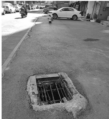
沈阳市浑南区学城路和文乐街交会处西北角,一个地排烟管道设置在了人行道的中间位置,上面没有任何遮挡,钢筋焊成的隔离网已经变形,稍不注意就会陷入其中。地面排烟管道本来就是违规设施,还存在这样严重的安全隐患,请相关部门进行及时处理。辽沈晚报记者 吉向前文并摄
