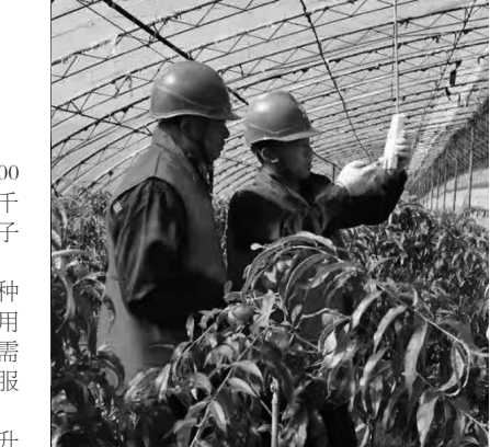
供电人员不定期走进大棚,为种植户检查用电设备。 朝阳供电公司供图
