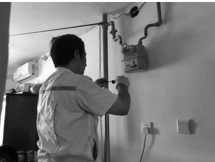
工作人员在重点群体家中安装“智能三表”。 沈阳市应急局供图
