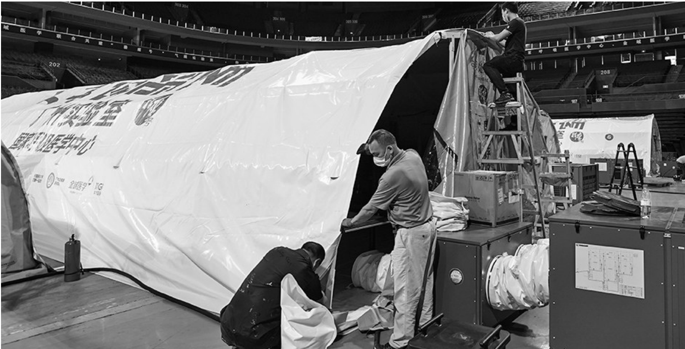
曾在广州全员核酸检测中发挥重要作用的“猎鹰号”气膜实验室运抵南京青奥体育公园体育馆,7月27日,工作人员在安装搭建“猎鹰号”气膜实验室。
