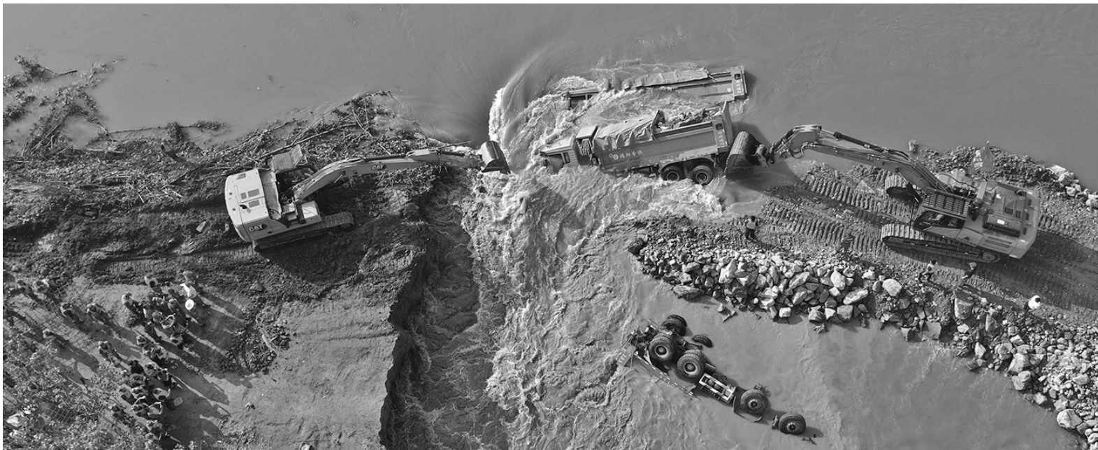
7月25日，满载石料的重型卡车被推入卫河鹤壁市浚县新镇镇彭村段的决口处(无人机照片)。新华社发
