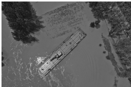
24日，中国安能应急动力舟桥赶到卫河进行决口封堵作业(无人机照片)。新华社发
