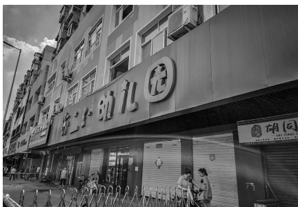
对面的幼儿园和商铺也受到不同程度的损坏。
