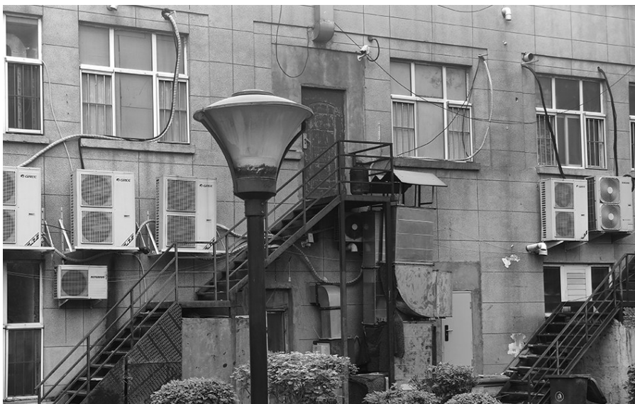
烧烤店烟道贴着居民楼外墙,向园区内排烟。
