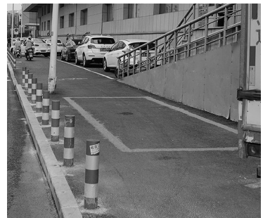
堵路的停车位已被抹掉，路面恢复通畅。
