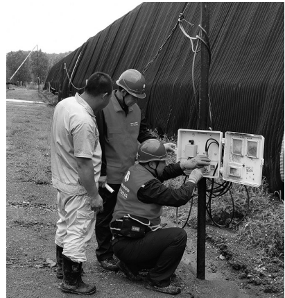
供电人员正在检查种植基地的电路。 葫芦岛供电公司供图
