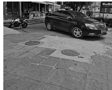
破损路面已修整。
