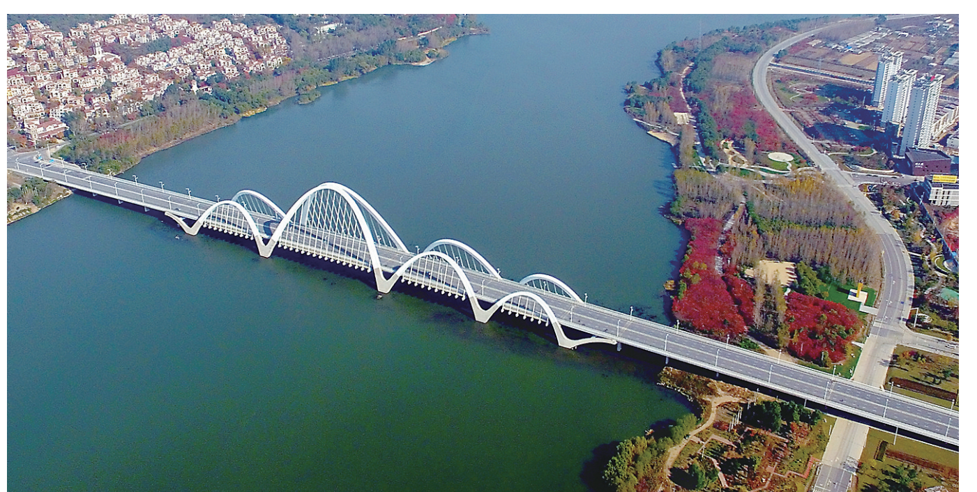
伯官大桥是中国首座六跨中承式飘带形提篮拱桥。 辽沈晚报记者 查金辉 摄
