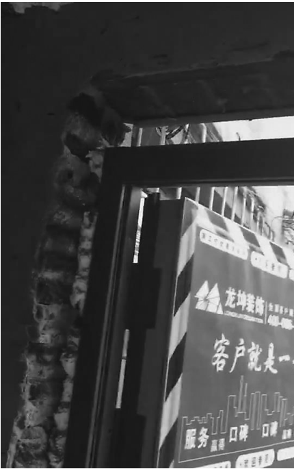
新订的阳台门，但砌阳台时门口留窄了，而上面却有一条5厘米多的缝隙。 视频截图
