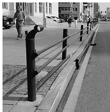
在南北快速路科普公园东门公交车站旁的人行道上,护栏最上面的三根横杆脱落,躺在边石旁。其中有两根横杆头上还连着支架,很容易被途经此处的机动车碾压,进而酿成险情,希望有关部门尽快维修处理。
