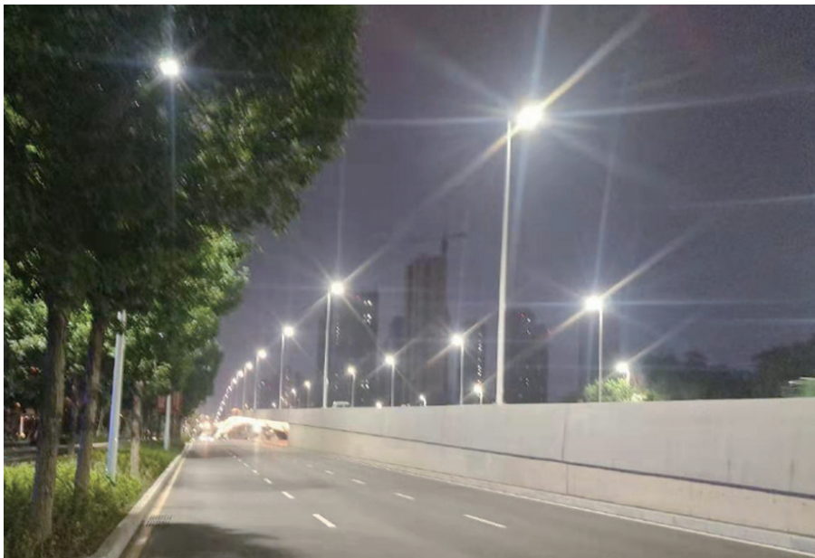
金阳大街路灯恢复照明。
