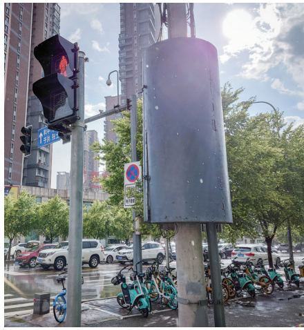
配电柜的金属门已修好。
