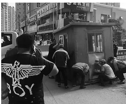
昨日,停车杆已拆除,看护亭正在拆除并给于暂扣处理。皇姑区供图
