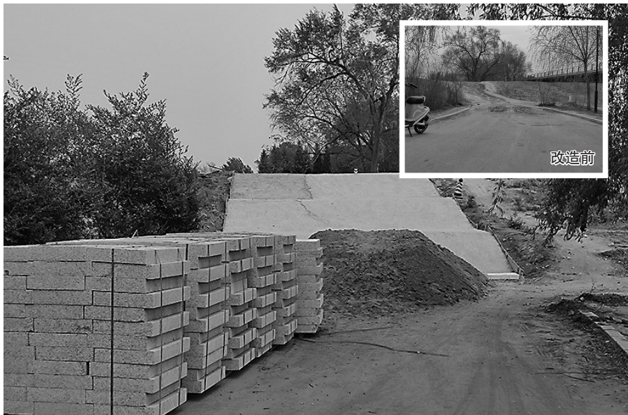
时隔一个多月,“越野路”终于开工改造了。
