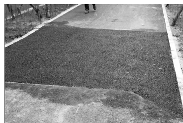
缺失沥青路面已经修复。 读者供图
