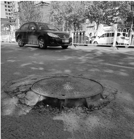
长白南路从和安街向东，不仅井盖突出地面，甚至有路面塌陷拿共享单车当“提示牌”。
