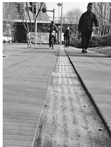
沈阳市浑南金帆西路南侧人行路盲道风化缺失严重。 辽沈晚报记者 王迪 摄
