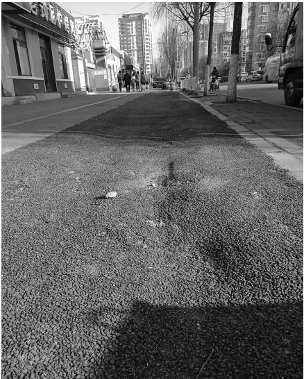
川江街路面回填后高低不平，变成“波浪路”。
