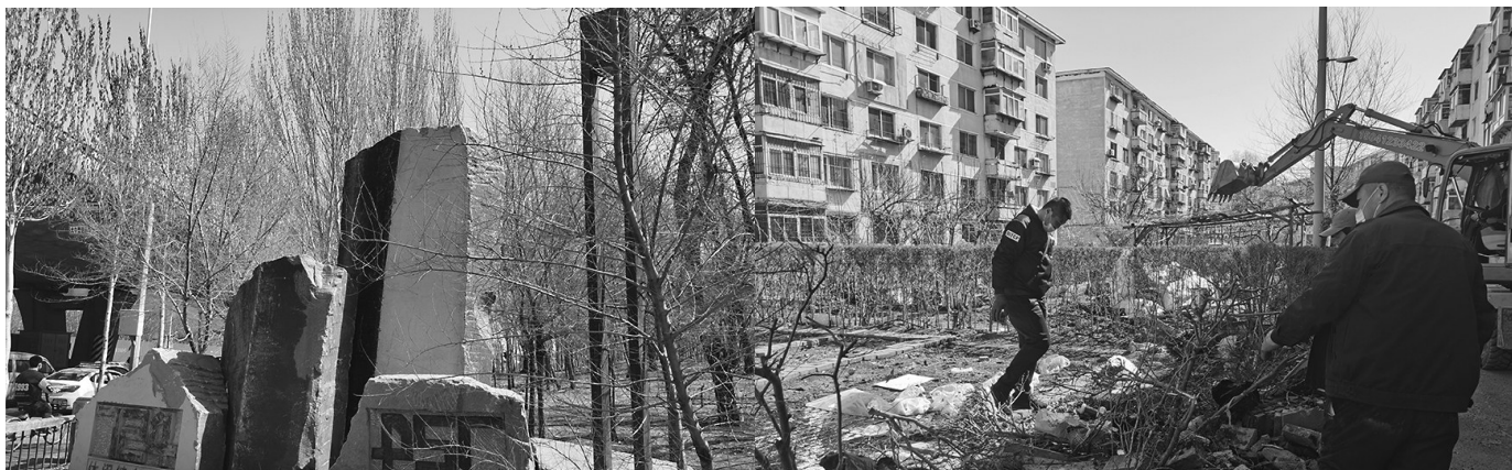
皇姑区针对列入今年改造计划的北陵、兴建等8个老旧小区迅速开展拆违治乱行动，打开空间，为改造施工打下坚实基础。皇姑区供图
