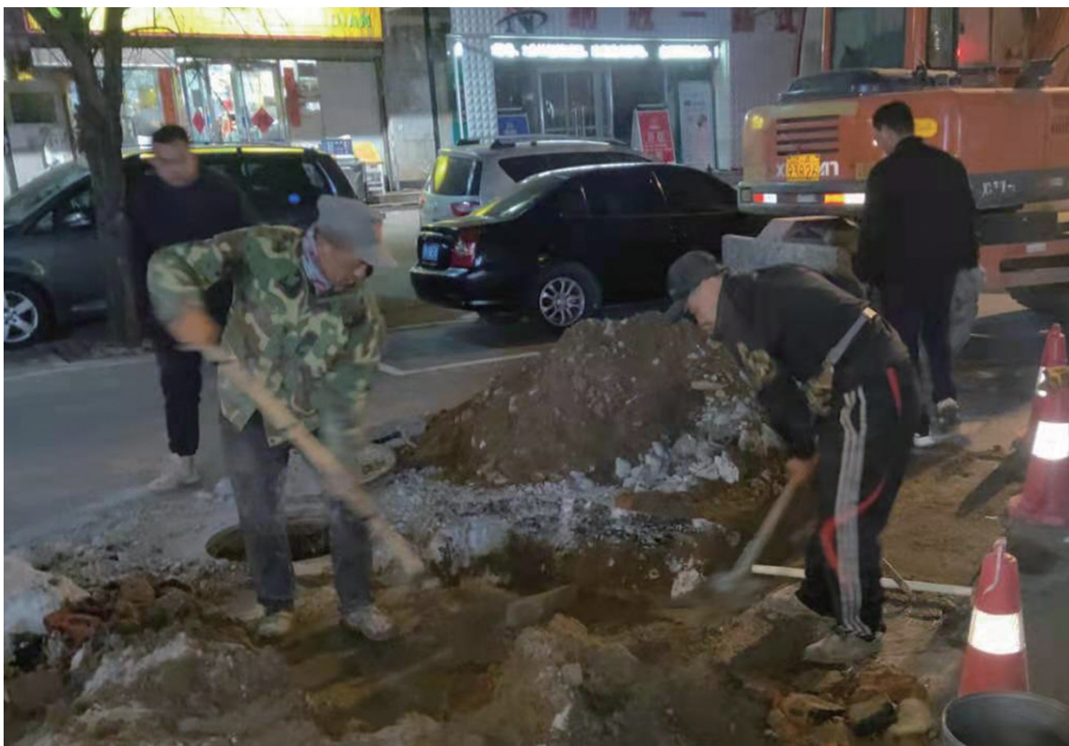
抢修结束后,工作人员在回填土方。
