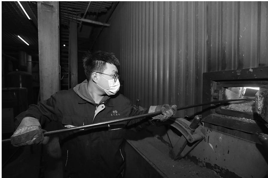
昨日,在沈阳惠天热电一处热源厂,工作人员通过锅炉观察口,观察煤炭燃烧情况。
