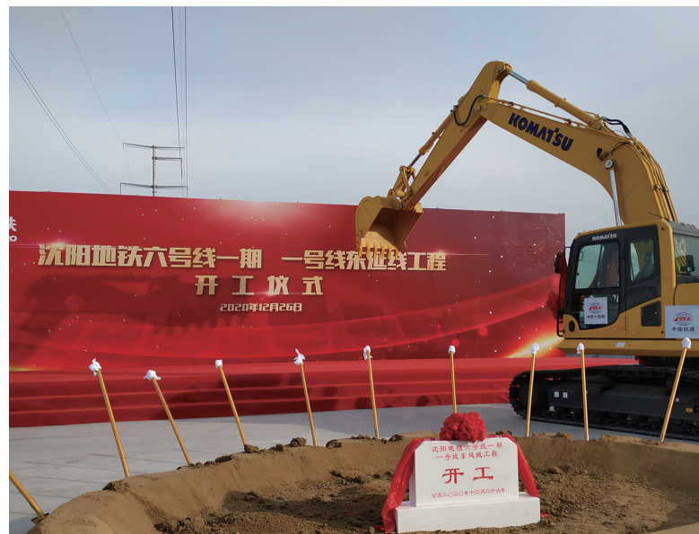
昨日,沈阳地铁六号线一期和一号线东延线工程开工。辽沈晚报记者 胡月梅 摄
