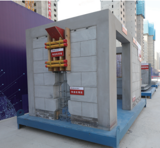
构造柱样板。
