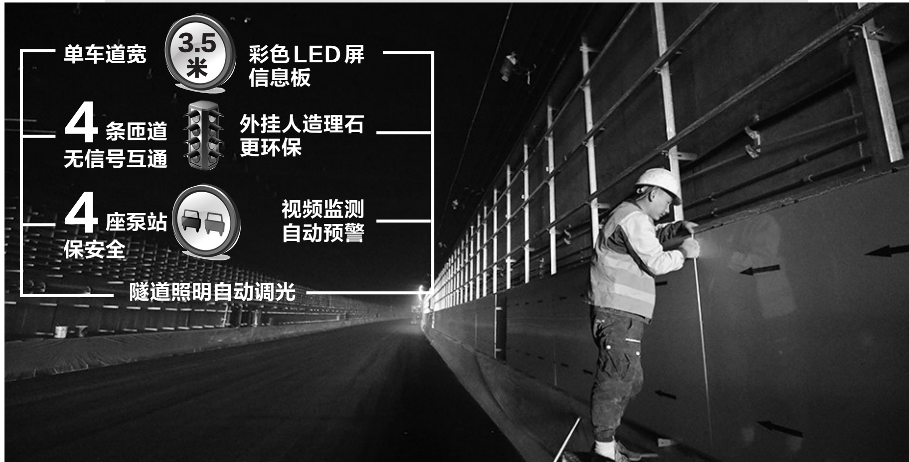
随着浑南大道快速路桥梁段全线通车,隧道段施工也进入倒计时,目前正在进行最后阶段的工程配套及内部装饰施工工序。
